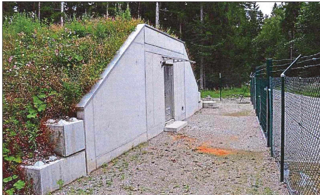
Die neuen Brunnen im Öttinger Forst (im Bild eines der beiden Brunnengebäude) wurden von den Gemeinden Burgkirchen und Kastl gemeinsam errichtet und gingen im Juli 2022 ans Leitungsnetz. Das Wasser, das aus diesen beiden Anlagen gefördert wird, hält nicht nur die Grenzwerte der Trinkwasserverordnung ein, sondern übertrifft sie weit.
