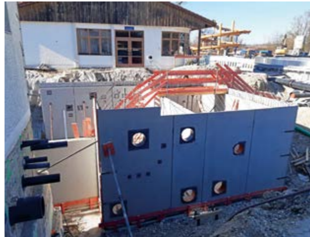
Die Wände des Untergeschosses mit vorgefertigten Öffnungen für Rohrleitungen
