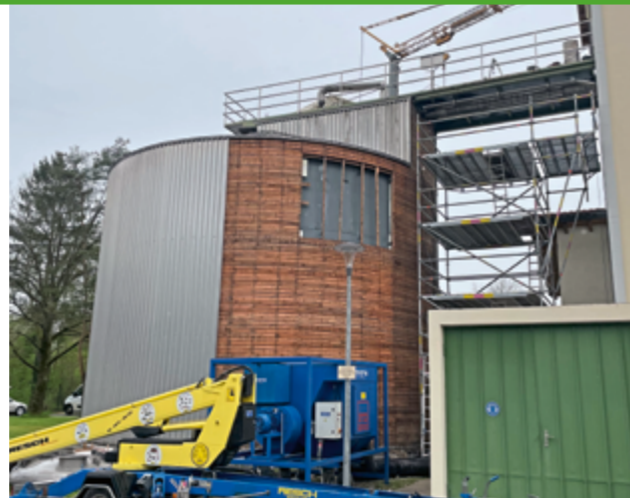
Im Stahlbehälter „fault“ der Klärschlamm aus. Dabei entsteht Klärgas, das im Blockheizkraftwerk für die Produktion von Strom genutzt wird. Dieser wird in der Kläranlage größtenteils für den Eigenverbrauch verwendet.
