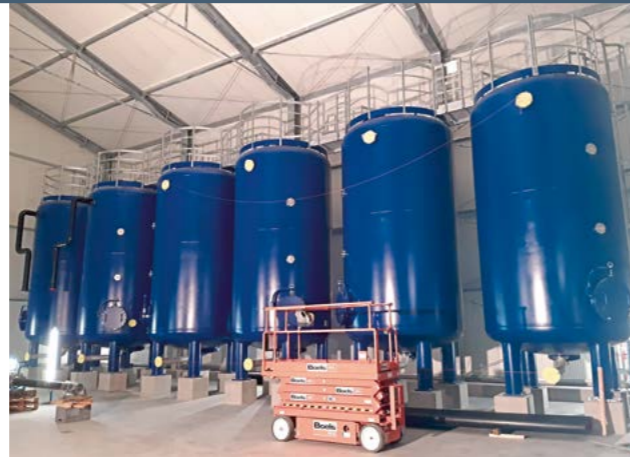
Die Adsorberbehälter sind bereits aufgestellt (Bild: Michael Prestel)
