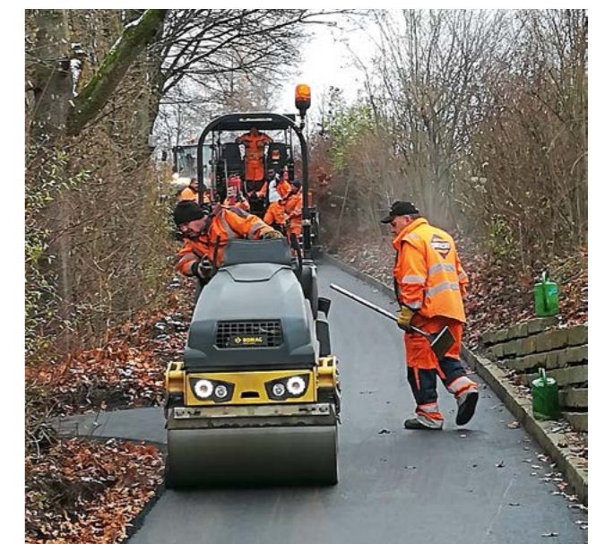
Die Asphaltfirma beim Einbau der Deckschicht am Reibwirtsberg (Bild: Alois Remmelberger)
