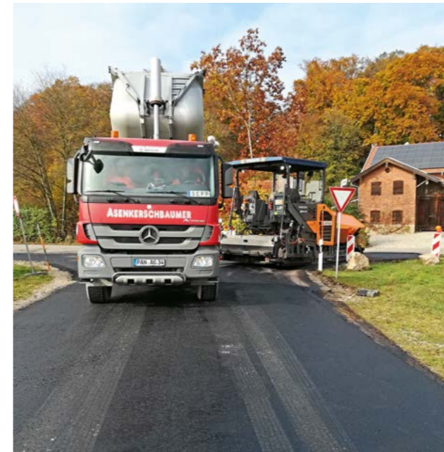
Der Helmlweg erhält die Asphalt-Deckschicht (Bild: Alois Remmelberger)
