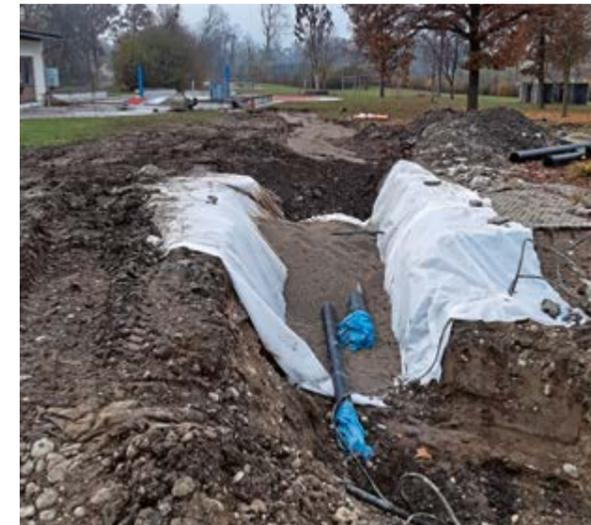
das Ausbetonieren der Behälterfüße, anschließend kann mit der Arbeit an den innenliegenden Rohrleitungen begonnen werden. Auch im Außenbereich werden die Sanierungsmaßnahmen fortgesetzt, so wurden vom bestehenden Planschbecken in Richtung Erlebnisbecken die ersten Meter Rohrgraben geöffnet und die vorbereiteten neuen Leitungen verlegt. So wird Zug um Zug der gesamte Beckenumgriff geöffnet, die Leitungen erneuert und an das neue Becken angeschlossen und der Graben wieder verschlossen.
