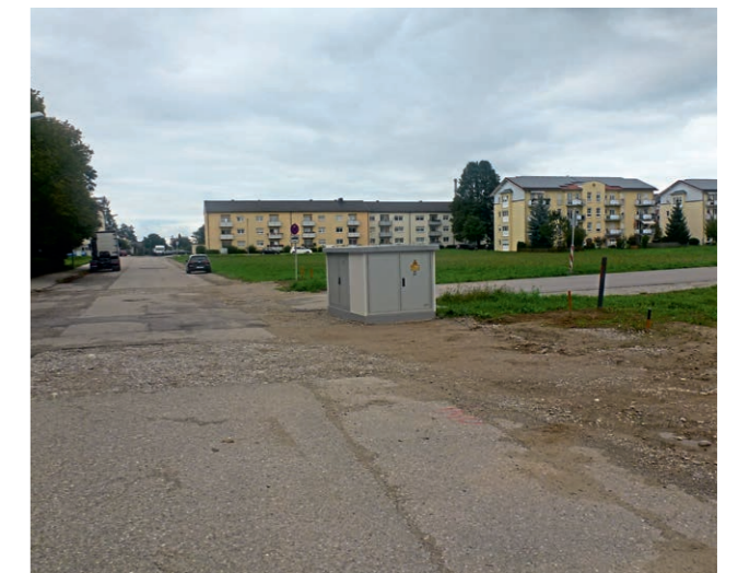
Schusterbauerstraße vor der Fertigstellung
