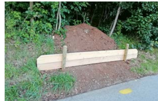
Bretter verhindern das Abrutschen der Nadeln auf den Radweg (Fotos: Alois Remmelberger)
