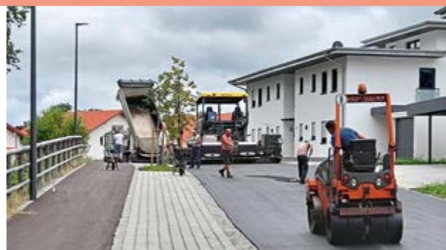
Asphaltarbeiten bei Obermühl
