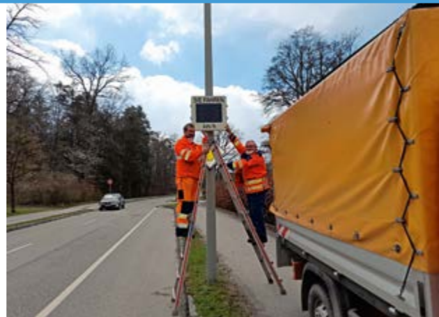
Bauhofmitarbeiter Martin Stadler und Stefan Hofbauer bei der Montage des Geschwindigkeitsanzeigergerätes (v. links) Foto: S. Wirtz
