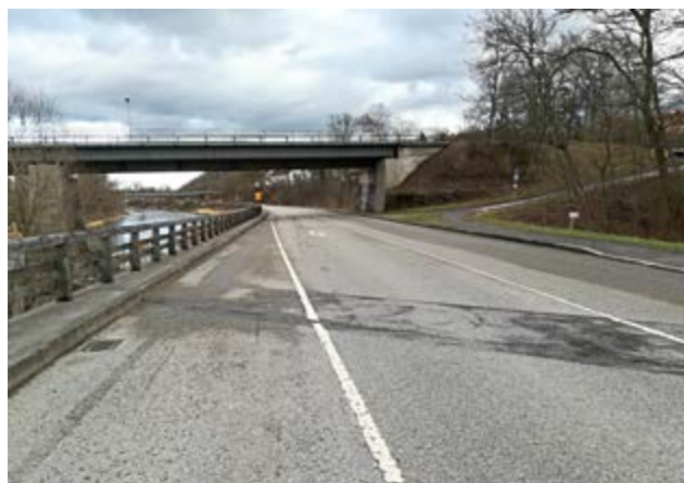
Entlastungsstraße an der Alz
