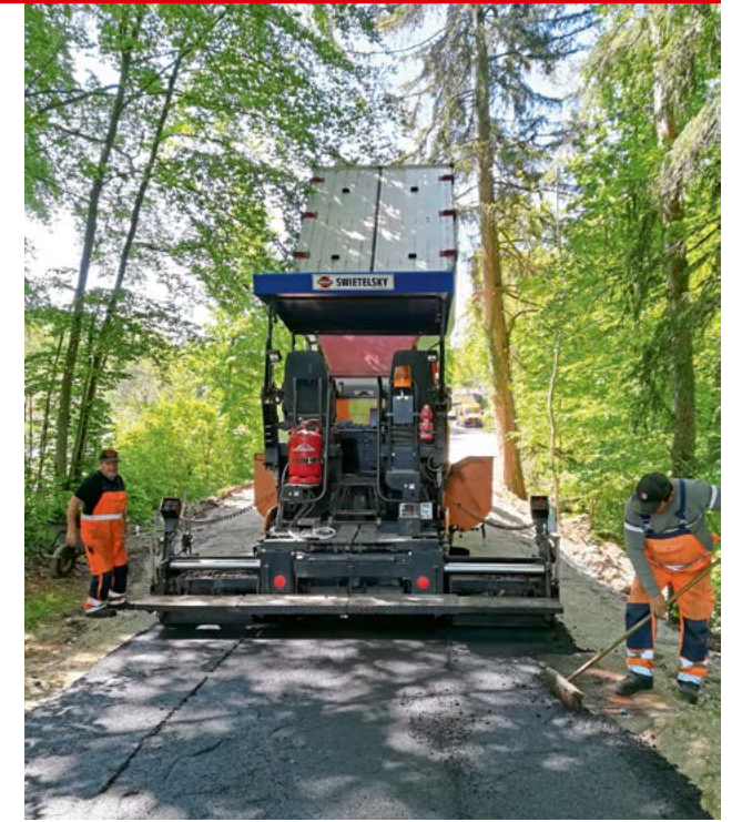
Der Radweg von Weberau zur Europabrücke wird neu asphaltiert (Foto: Alois Remmelberger)
