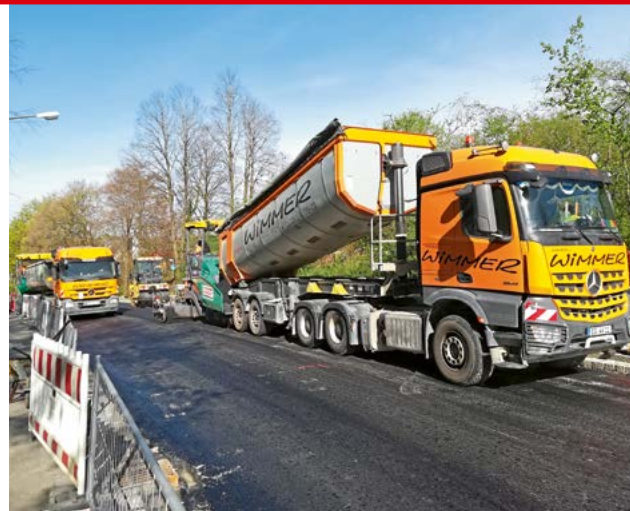
Mit 2 Asphaltfertigern wurde die Asphaltsschicht in der Ortsdurchfahrt eingebaut
