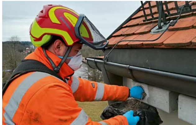
Robert Mellack vom Bauhof reinigt die Mauersegler-Nistkästen, damit ab Mai die neuen Nester gebaut werden können
