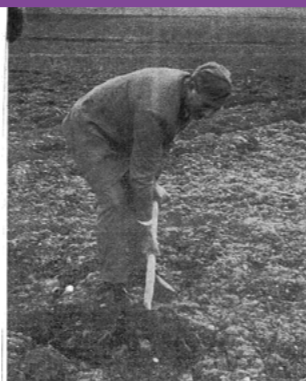
Bürgermeister Andreas Voderhuber beim Spatenstich in Holzen
