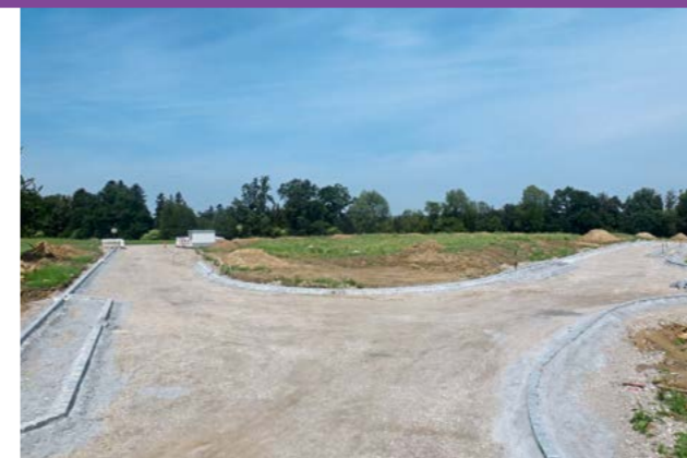
Ortsstraße im Baugebiet Wimpasing II
