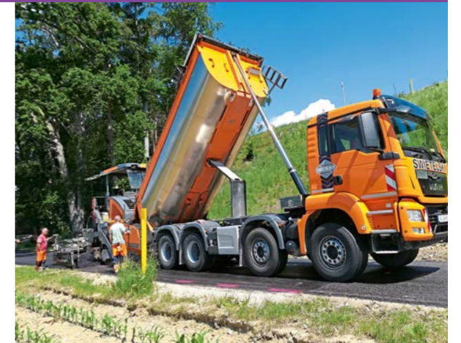
Der Asphaltfertiger baut die neue Deckschicht ein (Foto: Remmelberger Alois)
