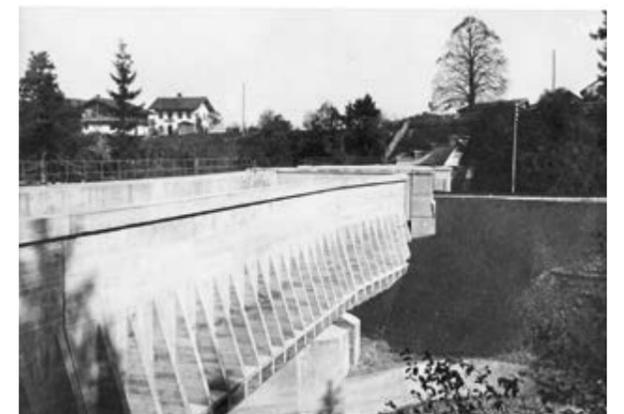
Der Halsbach wurde mit einem Betontrog über- und das Bahngleis mit einem Betondücker unterquert
