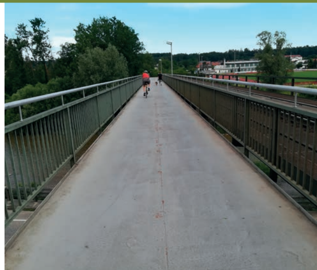
Auf dem Stahlsteg über die Alz wurden die Geländer für Radfahrer auf beiden Seiten (je 110 m) auf 1,30 m erhöht. (Foto: Alois Remmelberger)
